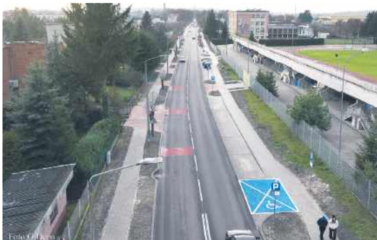
Przebudowa ulicy Piłsudskiego w mieście Krasnostaw
