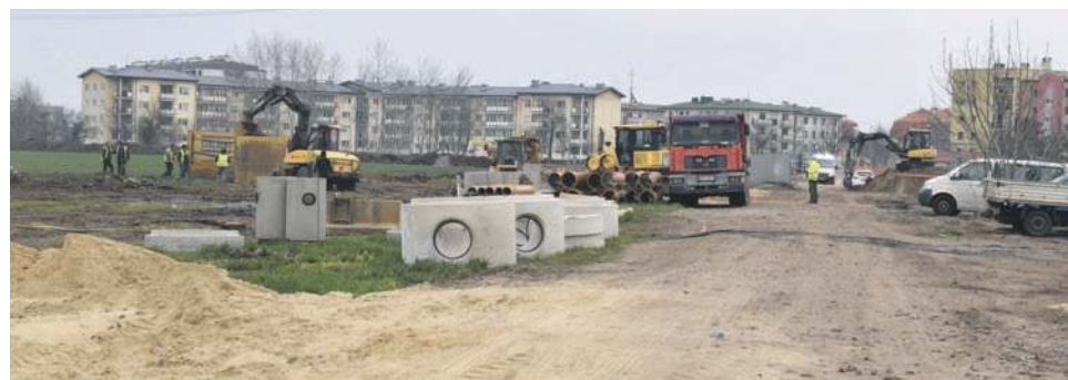
Drogi dojazdowe już powstają
