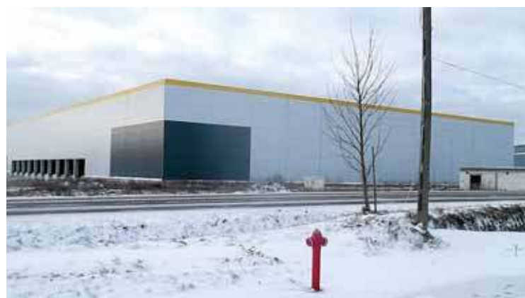
Hala magazynowa w Szydłowie, stan obecny
