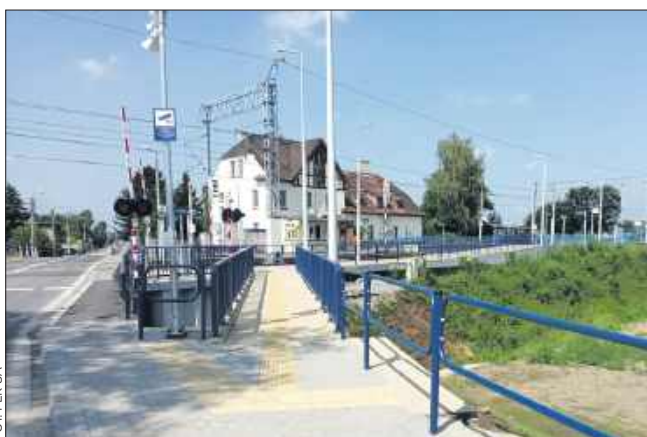
■ Podróżni nie muszą już przechodzić przez tory, aby dostać się na perony stacji Olza. Polskie Linie Kolejowe wybudowały nowe dojścia i zmodernizowały pobliski przejazd.
