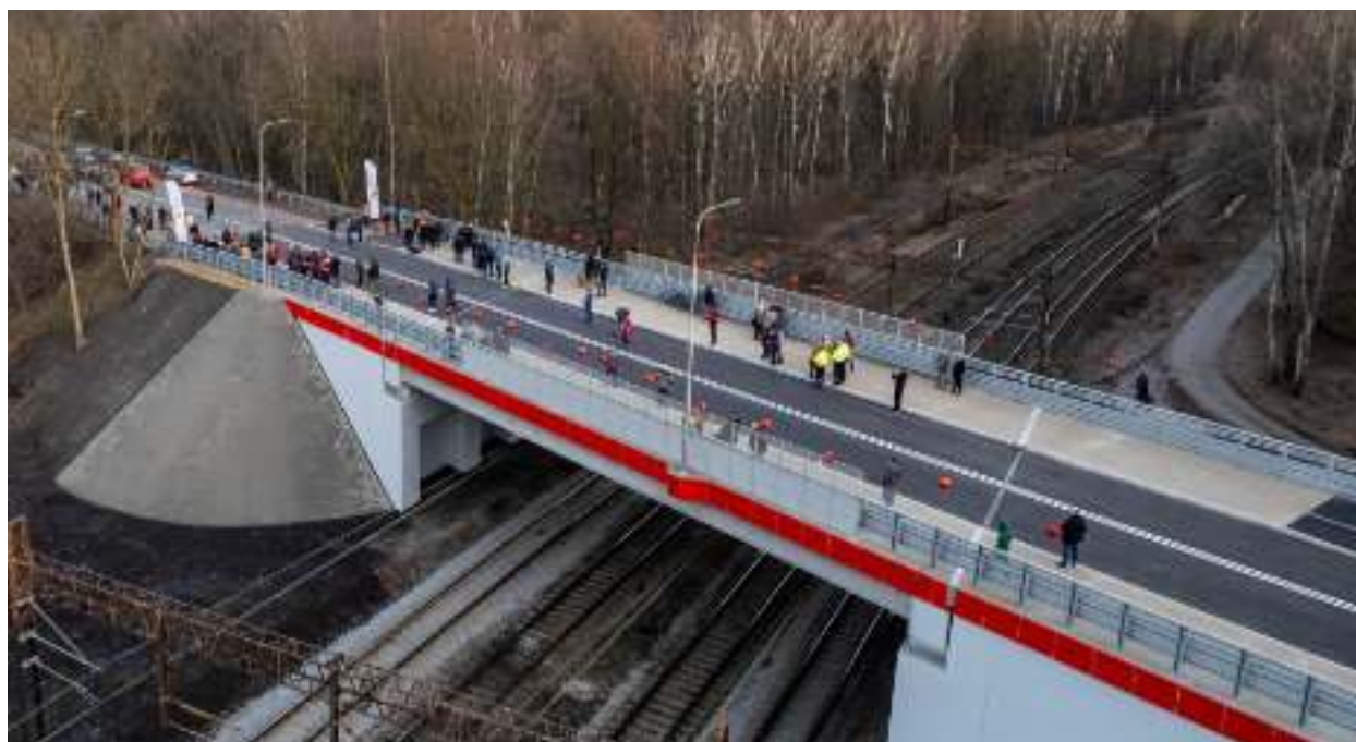
► W miejscu rozebranego wiaduktu powstał całkowicie nowy obiekt Fot. UM Zabrze
