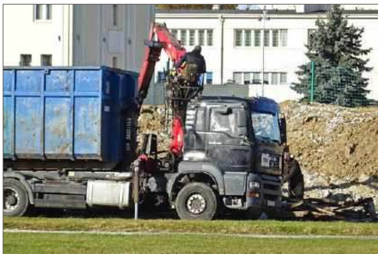
Stara trybuna jest już rozbierana. Kiedy powstanie nowa, nie wiadomo.
