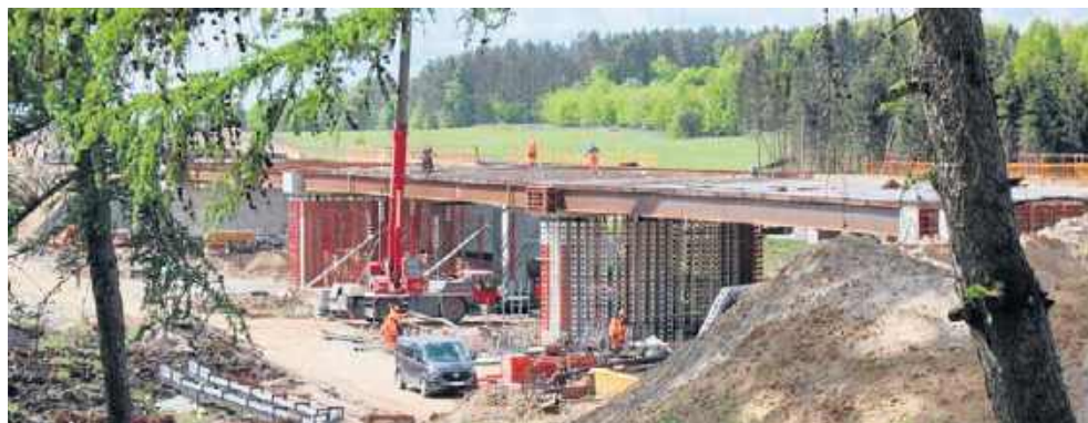
Budowa drogi ekspresowej S11 w Wielkopolsce pozostaje jedną z najbardziej wyczekiwanych inwestycji drogowych w regionie.
