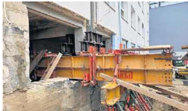
Aby stworzyć nowoczesną Centralną Sterylizatornię, konieczne było... podniesienie części szpitalnego budynku o jeden centymetr.
