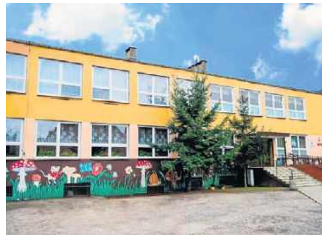
W Przedszkolu nr 7 powstanie Miejsce Doraźnego Schronienia.
