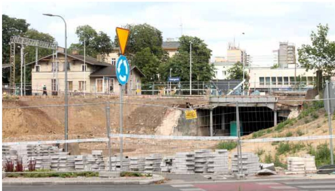
Odbudowany obiekt zostanie poszerzony, kierowcy zyskają szerszą jezdnię, a dla pieszych i rowerzystów po obu stronach powstaną chodniki oraz ścieżki.
