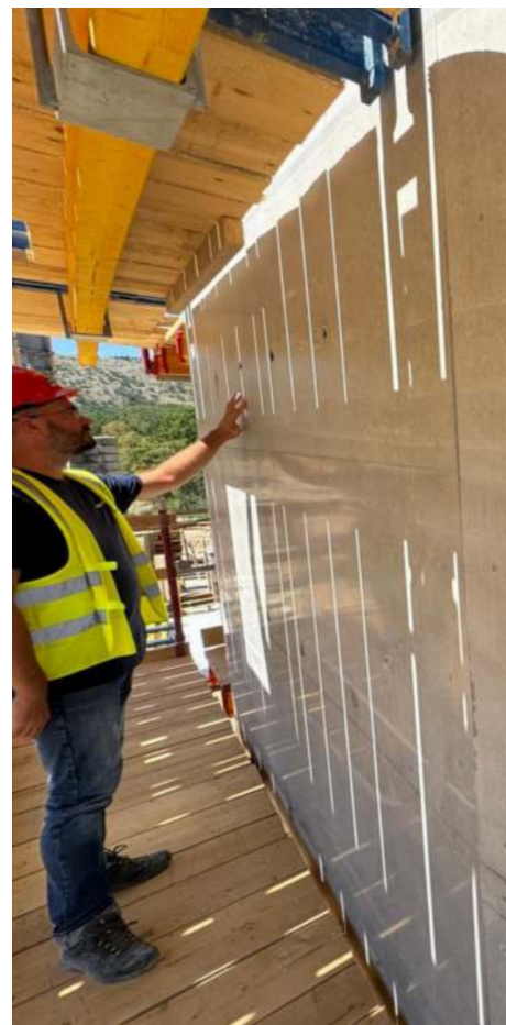
Fot. 6. Budowa zbiornika z zaokrąglonymi narożnikami – zastosowanie płyty CURVY BOARD o grubości 18 mm
