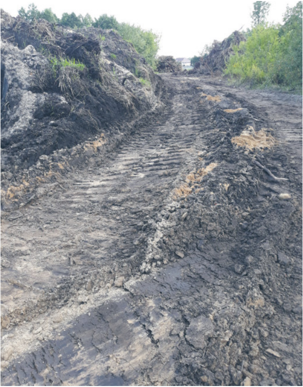
Budowa autostrady to nieodłączna dewastacja przyległych gruntów
