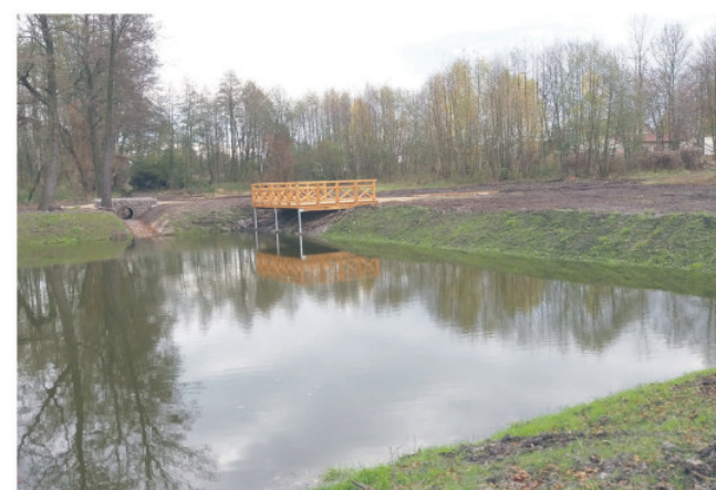
Zbiornik wodny na terenie Specjalnego Ośrodka Szkolno-Wychowawczego
