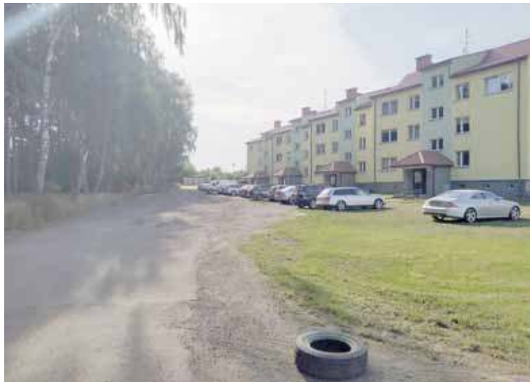
Nawierzchnia nie jest wcale przystosowana do przyjęcia ciężkich pojazdów dostawczych
