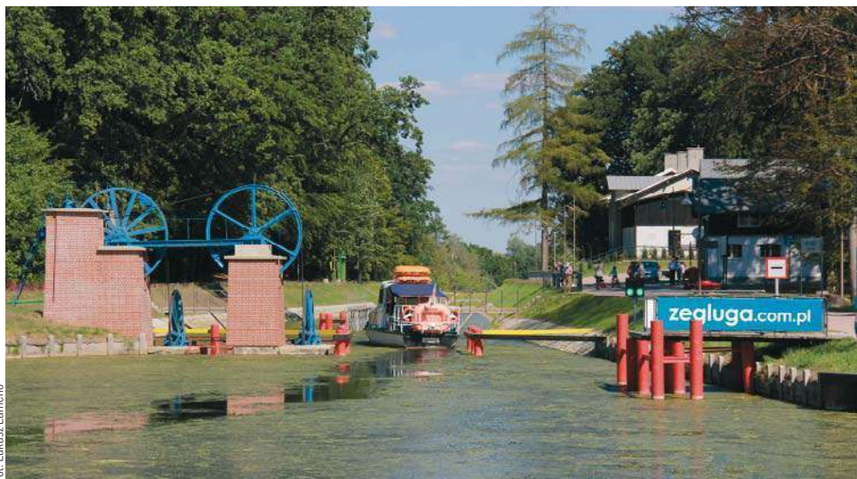
Droga dojazdowa do Buczyńca należy dla Nadleśnictwa Dobrocin, pole namiotowe do starostwa w Elblągu. Pochylnie do PGW Wody Polskie. Przyległe obiekty do samorządów i podmiotów prywatnych
