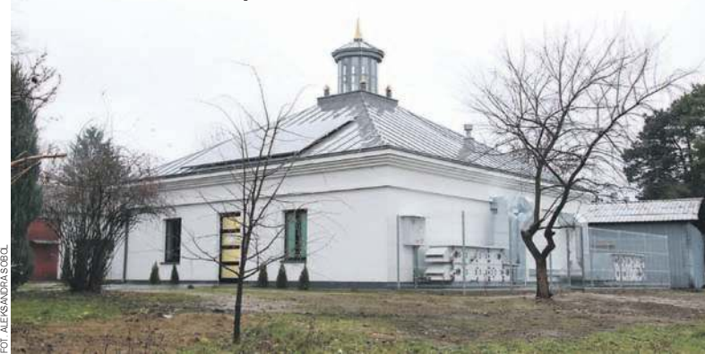
Przebudowa prosektorium prowadzona była pod nadzorem konserwatora zabytków
