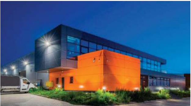
Kryształową Cegłę w kategorii Obiekty Przemysłowe i Infrastrukturalne zdobyła hala produkcyjno—magazynowa z budynkiem socjalno-biurowym przy ul. L.Spiessa 5 w Lublinie. Inwestor: GORBI PIOTR GARBACZ. Biuro Projektowe / Wykonawca: CoBouw Polska Sp. z o.o., Łódź – Pan Prezes Amsing Josephus Harmannus
