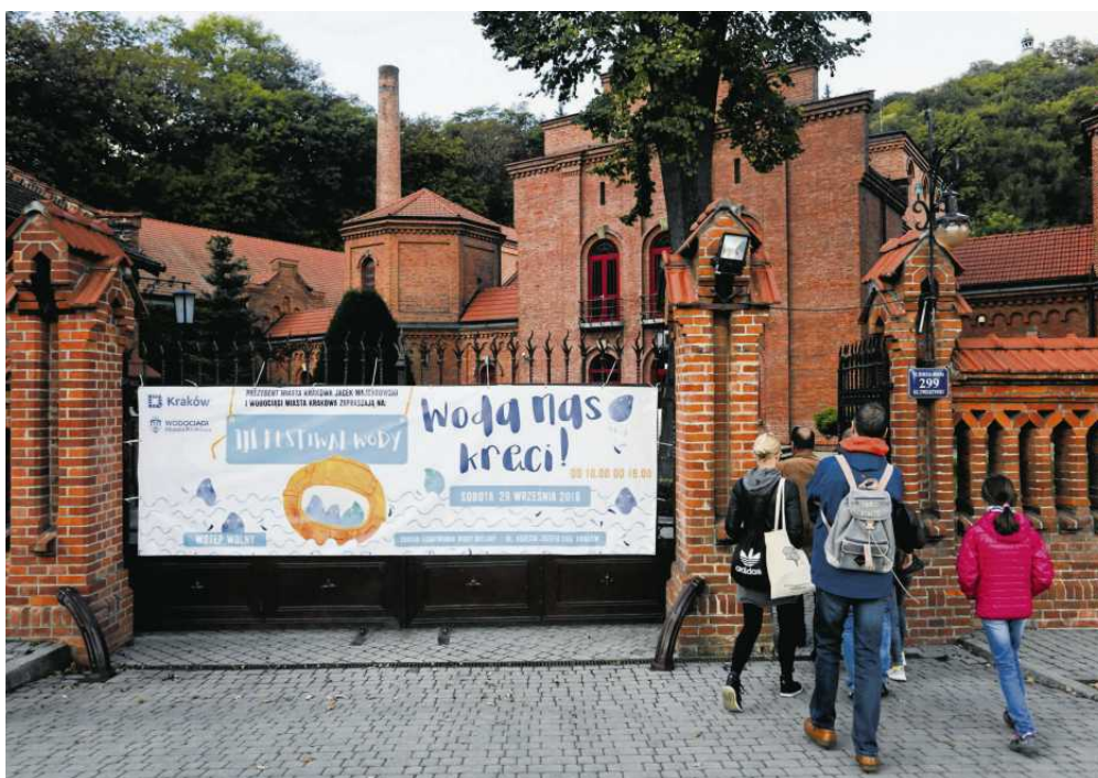
• Zakład Uzdatniania Wody Bielany
