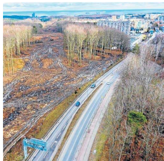
Wykonawca rozpocznie roboty od wrywania karpin, następnie rozpocznie prace ziemne
