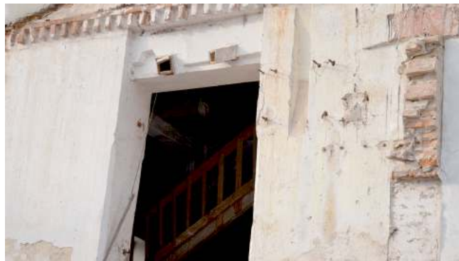
Rozbiórka przybudówki odsłoniła okazałe drewniane elementy konstrukcji i schody wewnątrz XIX-wiecznego budynku
