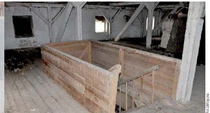
Rozbiórka przybudówki odsłoniła okazałe drewniane elementy konstrukcji i schody wewnątrz XIX-wiecznego budynku
