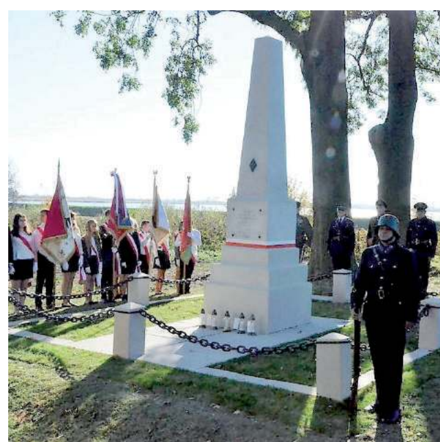
Oprócz tego, że pomnik zyskał nowy blask, specjalną masą uzupełniono w nim ubytki i zabezpieczono obelisk przed czynnikami atmosferycznymi. Obelisk mierzący około 5 m wykonany jest z bloków piaskowca, spojonych zaprawą wapienno-piaskową
