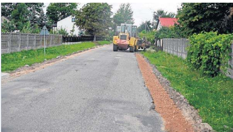
Przebudowa drogi między Podlesiem a Ratoszynom w gminie Radzanów. Drogowcy wykonują podbudowę pod poszerzenie jezdni.
