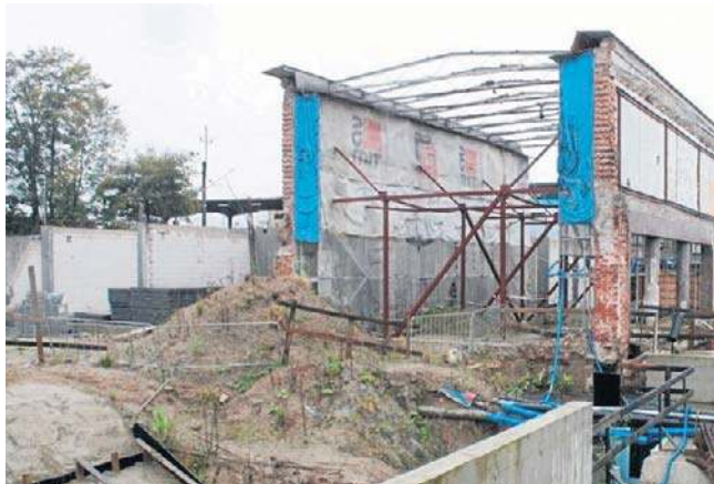
Termin składania ofert na dokończenie budowy dworca kolejowego w Koszalinie ponownie został zmieniony
