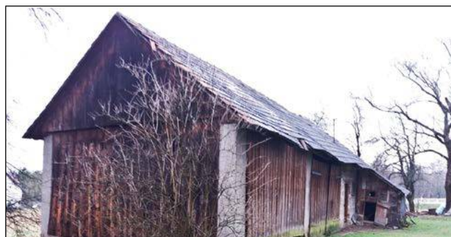
Przy rozbiórce stodoły nieubezpieczony pracownik złamał nogę.
