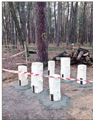
Nowa infrastruktura już powstaje w Chotowej.
