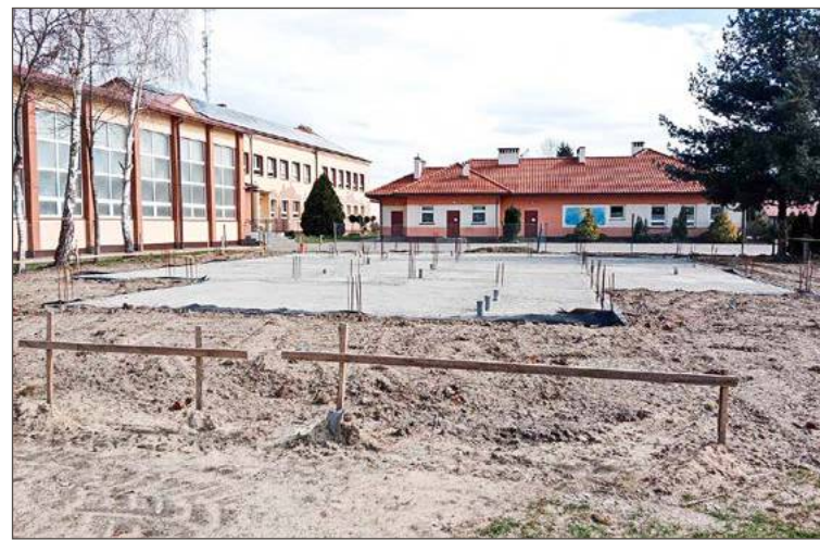
Lada dzień ruszą prace II etapu budowy ośrodka zdrowia.
