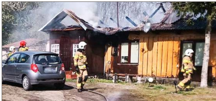
Prawdopodobną przyczyną pożaru było zwarcie instalacji elektrycznej. Fot. OSP Straszecin.
