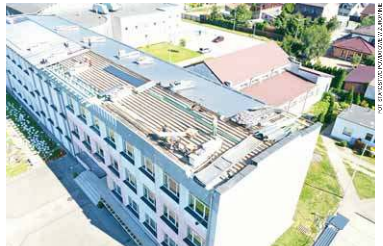
Trwają prace przy zmianie pokrycia dachowego na budynku LO im. Marii Dąbrowskiej w Żurominie.
