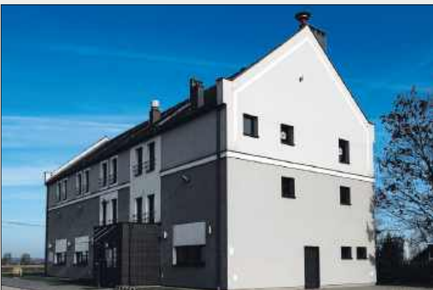
■ W nowej siedzibie straży pożarnej znajdują się dwa stanowiska na samochody bojowe
