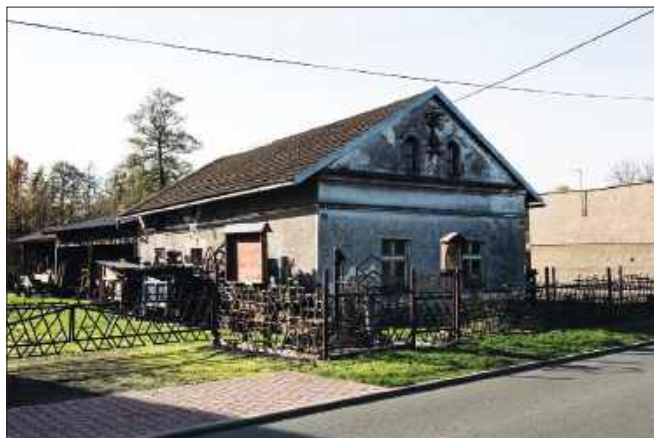
■ Wybudowany w 1879 roku dom szewca
