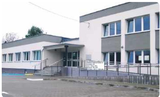
Gminne Centrum Kultury w Kamieniu
