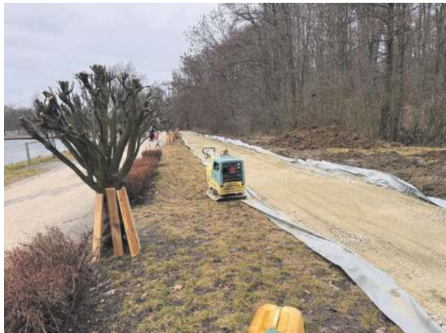
Tak wyglądała budowa podczas rozpoczęcia inwestycji
