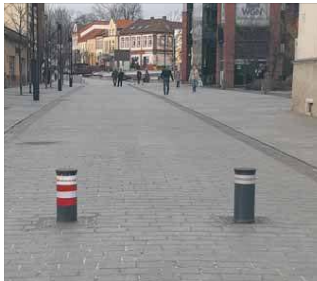
Słupki po kolejnej naprawie
