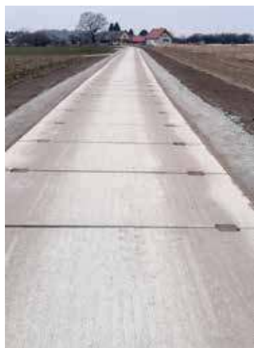
Droga w Czarnogłowach została przebudowana (fot. Gm. Przybiernów)
