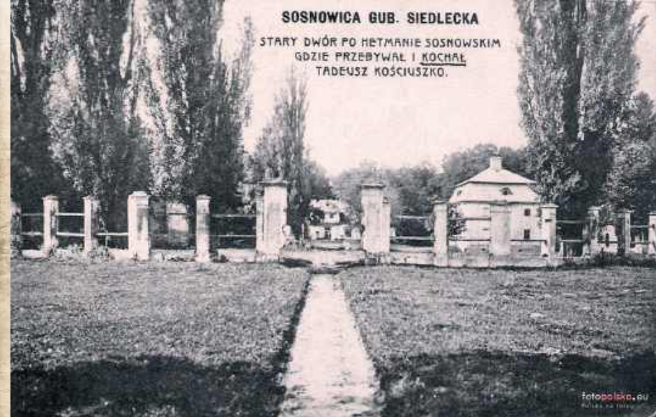
Do dziś zachował się budynek z prawej strony, właściwy pałac nie istnieje. Zdjęcie ok. 1910 roku znalezione na portalu fotopolska.eu. Nie wiemy, kto dokonał uroczego opisu
