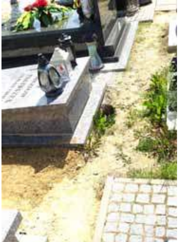
Ślady uszkodzeń po nawałnicy
