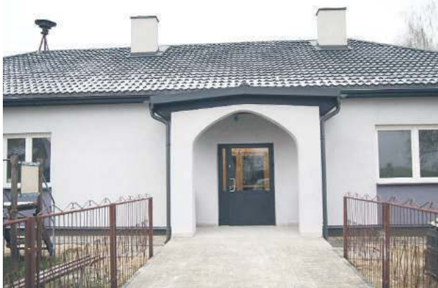
Wyremontowana świetlica w Ignatowie-Kolonii
