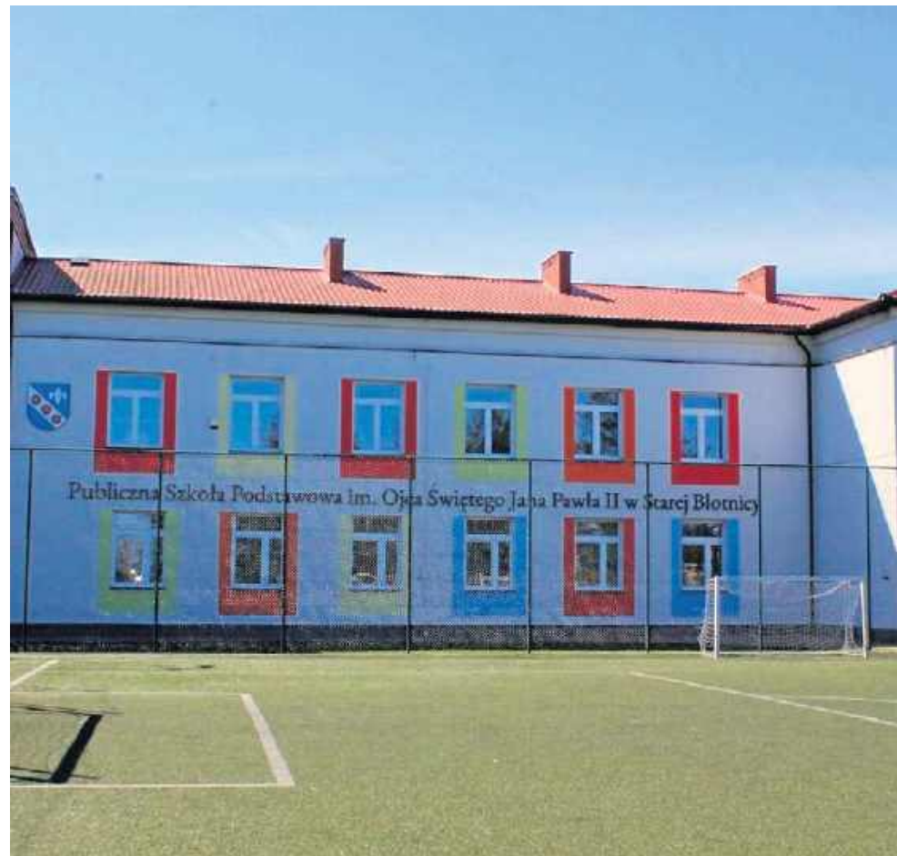
W Publicznej szkole Podstawowej w Starej Błotnicy rusza remont piwnic.
