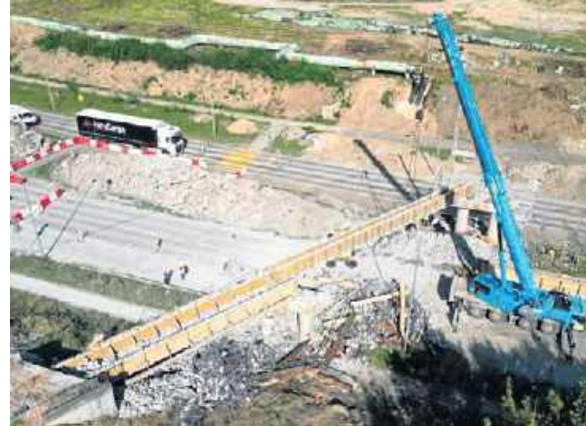
W Kielcach trwa rozbiórka wiaduktu kolejowego - jeden z najbardziej widowiskowych etapów budowy S74
