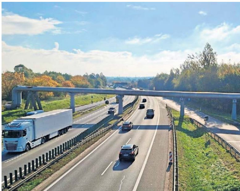
Dziś wieczorem zaczną się remonty na autostradzie A4. Będą utrudnienia na południu Krakowa
