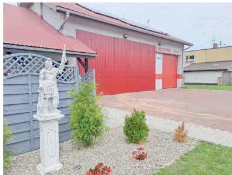
Budynek remizy został naprawiony (fot. OSP Lubczyna)
