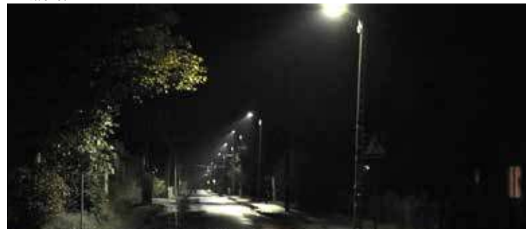
Wraz z przebudową drogi powstała zupełnie nowa instalacja oświetleniowa, niestety na razie musi być wyłączona
