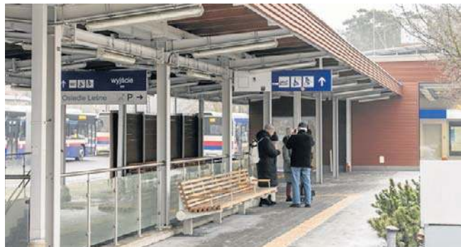
Późnym popołudniem podróżni już nie mogą ogrzać się w budynku przystanku Bydgoszcz-Leśna
