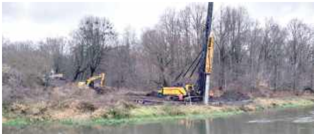
Praca palownicy nad brzegiem rzeki Wieprz
