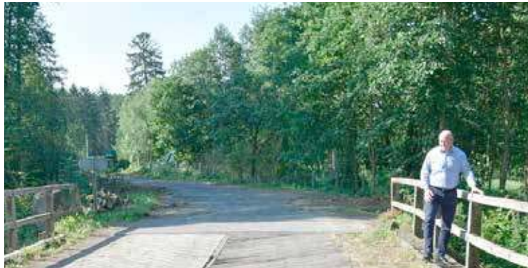
Starosta powiatowy odwiedził teren budowy (fot. Pow. Goleniowski)
