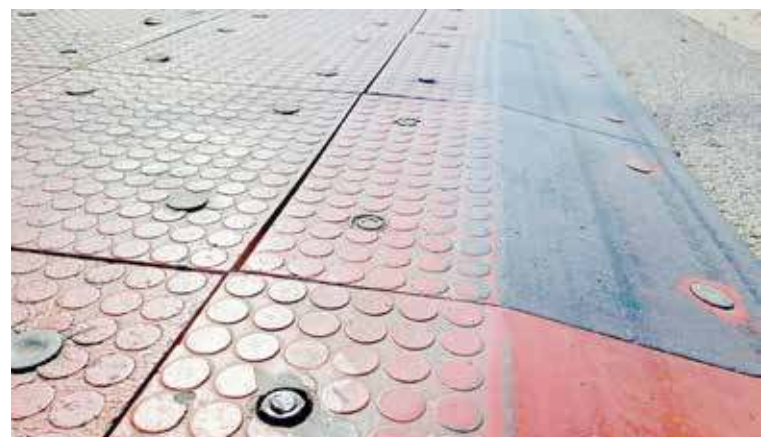
Zbyt krótkie kołki mocujące skutkują zrywaniem progów zwalniających (fot. Sołectwo Lubczyna)
