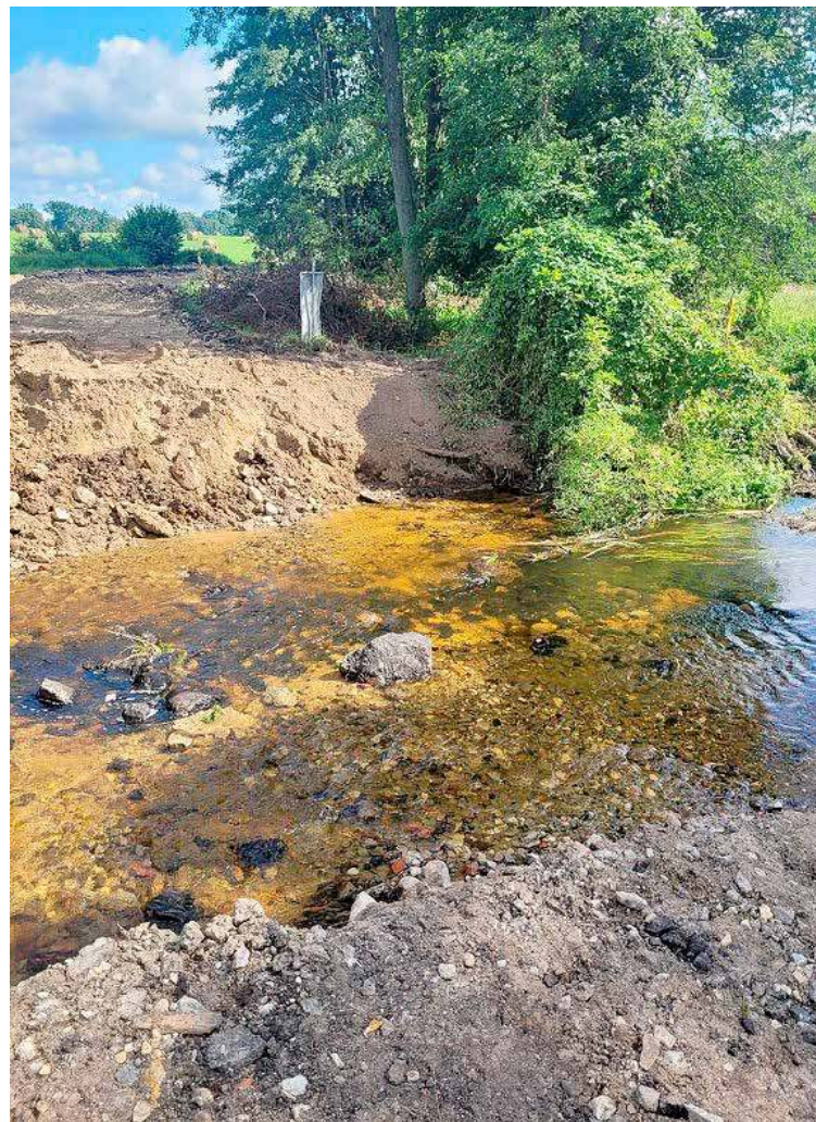
Prowadzone są prace związane z przebudową mostu (fot. Pow. Goleniowski)
