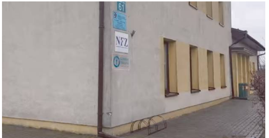
Obecny stan ośrodka zdrowia w Pruszyńcu
