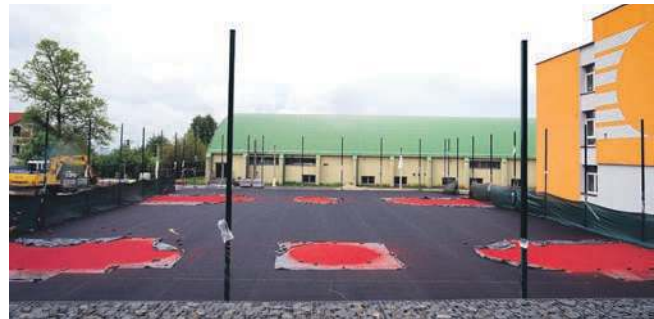
Trwa budowa nowych boisk przy podstawówce w Alwerni
