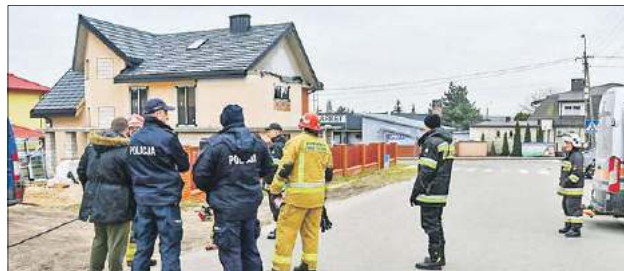
Uszkodzony podczas prac budowlanych gazociąg stworzył realne niebezpieczeństwo wybuchu, dlatego z okolicznych domów ewakuowano mieszkańców i zablokowano drogę
