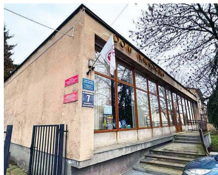
Ratusz chce wyremontować budynek tzw. Domu Nauczyciela
