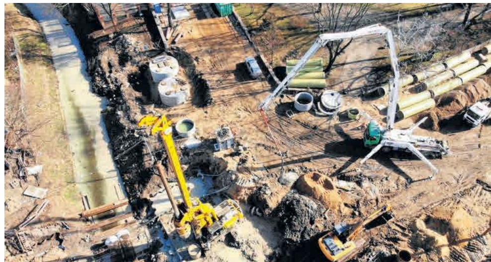
Przebudowywane skrzyżowanie u zbiegu Unii Lubelskiej, Fabrycznej, Zygmuntowskich, 1 Maja
