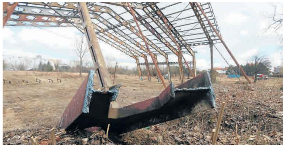
Stalowa konstrukcja niedoskiej hali sportowej przy ul. Jutrzenki przez dziesiątki lat straszyla swoim wyglądem. Ma być rozbrana w ciągu dwóch najbliższych tygodni
