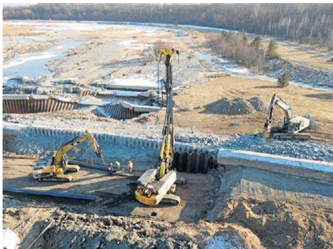
Na zdjęciu fragment prac przy zbiorniku
