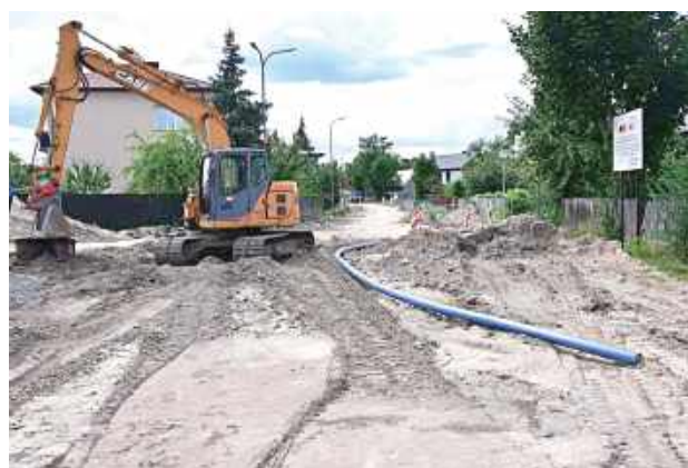
Trzeba uzbroić się w cierpliwość. Prace weszły w ostatnią fazę
