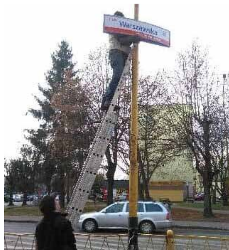
Wczorajszy montaż podświetlanej tablicy z nazwą ulicy, w tym przypadku ulicą Warszawską
