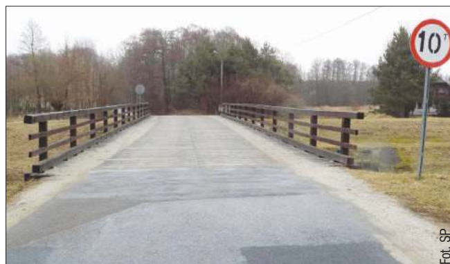
Most w Wampierzowie to ostatni tego typu przejazd w gminie Wadowice Górne.
