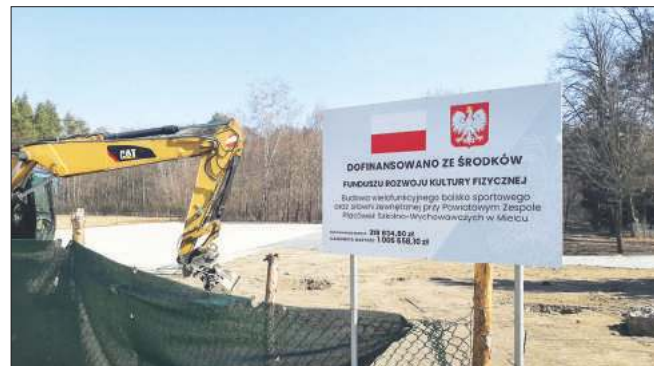
Na terenie Powiatowego Zespołu Placówek Szkolno - Wychowawczych w Mielcu realizowana jest budowa wielofunkcyjnego boiska sportowego.
