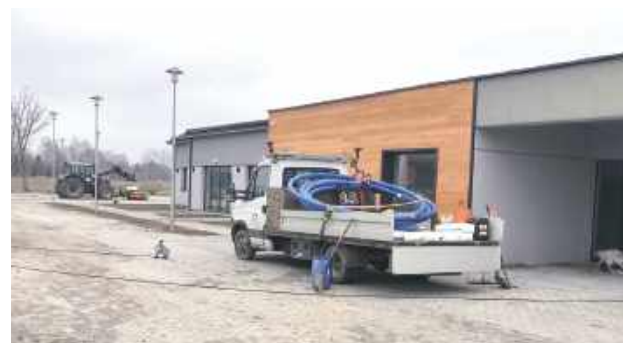
Coraz bliżej końca budowy przedszkola i żłobka
