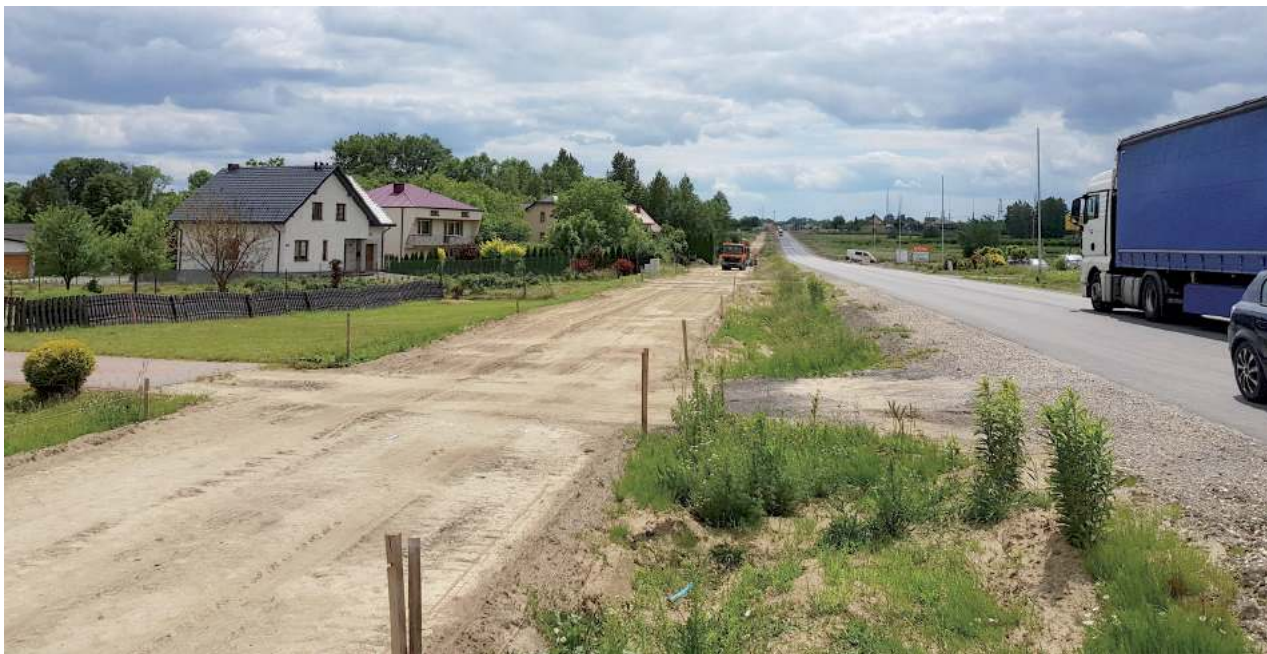
Zdjęcie z 15 czerwca, na którym widać zdemontowane już teraz mostki
