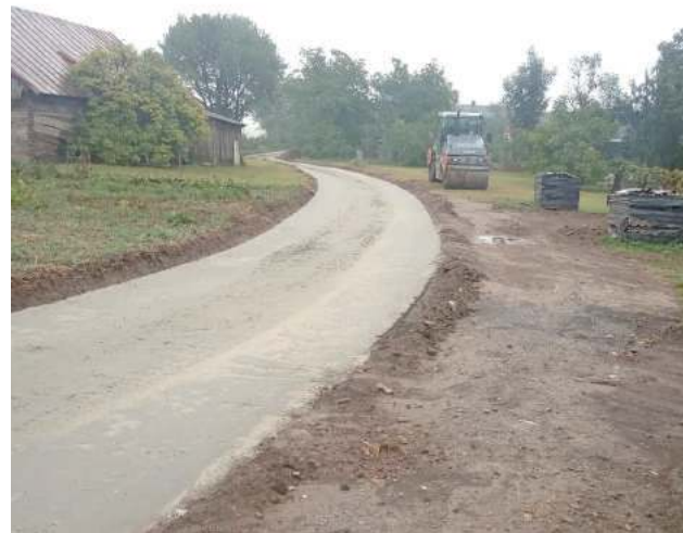
Droga w Tokarach jest już niemal gotowa
