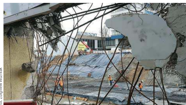
Nowy dworzec ma być gotowy w tym roku
