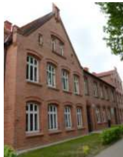
► Szkoła przeszła termomodernizację Fot. UM Zabrze
