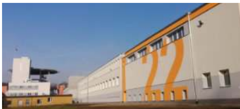
► Szkoła Podstawowa nr 22 po termomodernizacji, w tle lądowisko dla helikopterów w Szpitalu Miejskim Fot. UM Zabrze
