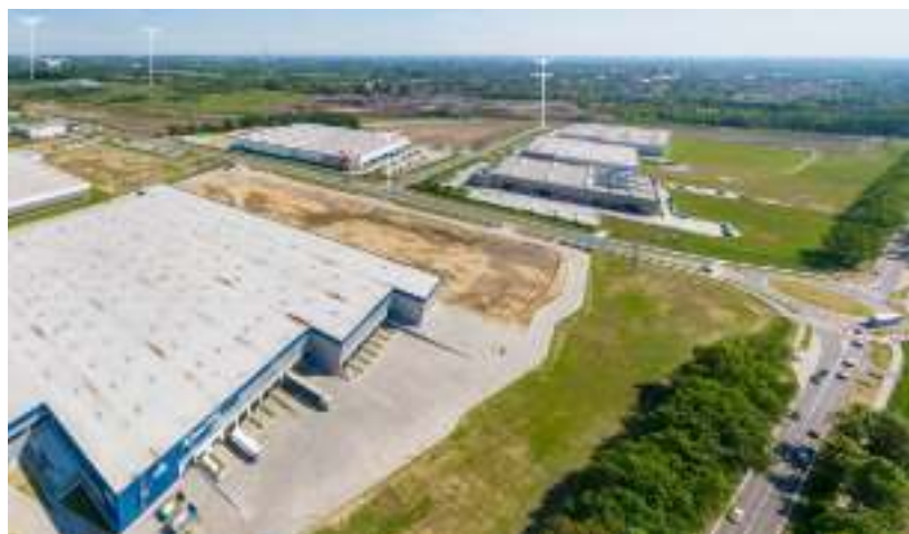
► Na terenie strefy działka już 19 firm Fot. UM Zabrze
