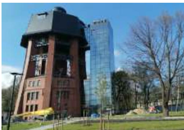
► Rewitalizacja wieży ciśnieni przy ul. Zamoyskiego Fot. Igor Cieśllicki
