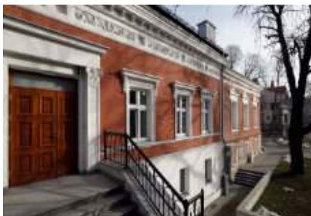
► Remont żłobka przy ul. Niedziałkowskiego Fot. UM Zabrze
