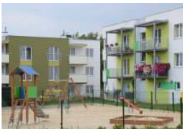
► Rozbudowa osiedla przy ul. Żywieckiej Fot. UM Zabrze
